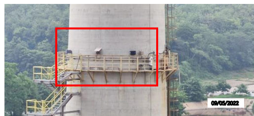
รูปที่ 2 - 14 CEMS STACK
