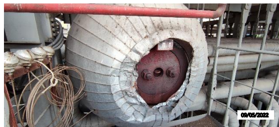
รูปที่ 2 - 53 Steam Drum ของหม้อไอน้ำ
