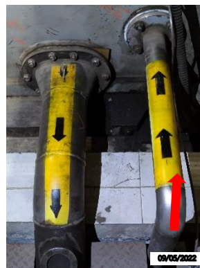
รูปที่ 2 - 64 ระบบท่อน้ำมันเลี้ยงแบรีง ของ Turbine&Generator
