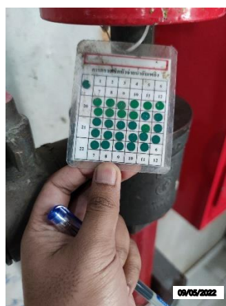
รูปที่ 2 - 51 การตรวจถังดับเพลิง
