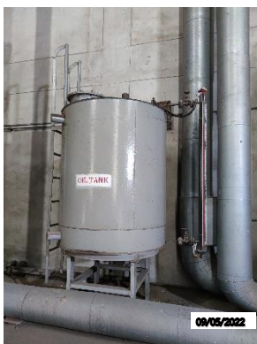
รูปที่ 2 - 65 Emergency Gravity Oil Tank
