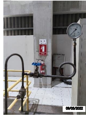
รูปที่ 2 - 59 Pressure Transmitter ของหม้อไอน้ำ
