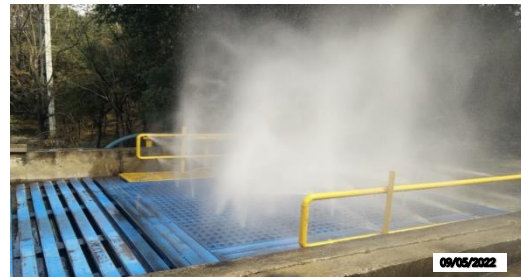
รูปที่ 2 - 37 ระบบการพ่นละอองน้ำเพื่อป้องกัน การฟุ้งกระจายของถ่านหิน
