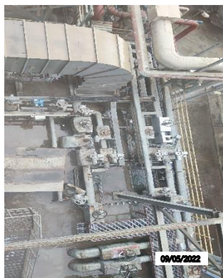
รูปที่ 2 - 47 ฉนวนกันความร้อนของระบบท่อไอน้ำ
