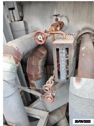
รูปที่ 2 - 61 เครื่องวัดระดับน้ำของหม้อไอน้ำ
