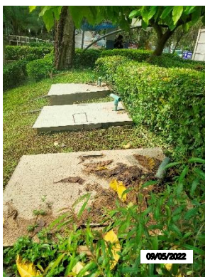
รูปที่ 2 - 30 ระบบบำบัดน้ำเสียสำเร็จรูป
