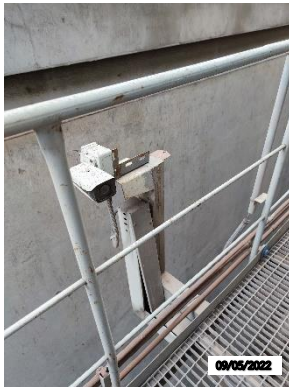
รูปที่ 2 - 58 การติดตั้งกล่องวงจรปิดสำหรับตรวจสอบ ระดับน้ำของหม้อไอน้ำ
