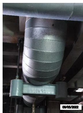
รูปที่ 2 - 57 Rapid Drain Piping System ของหม้อไอน้ำ
